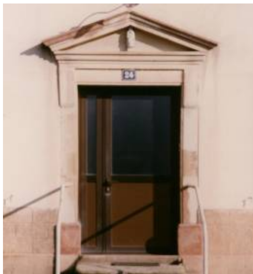
La principale porte d'entrée en pierre de taille des carrières d'Offemont aura quatre pieds de largeur et six pieds de hauteur surmontée d'une double corniche
