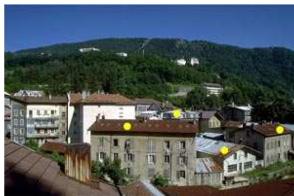
Les bâtiments de l'entreprise Odobey Vue de dos par rapport au dessin du papier entête. On reconnaît (points jaunes) le hangar allongé, avec de part et d'autre deux bâtiments de l'entreprise et derrière le toit en zinc de la maison de Paul Odobey, construite en 1900. L'immeuble blanc en second plan est récent
